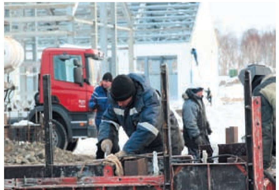
Строительство объектов транспорта газа на Дальнем Востоке ведётся ударными темпами
